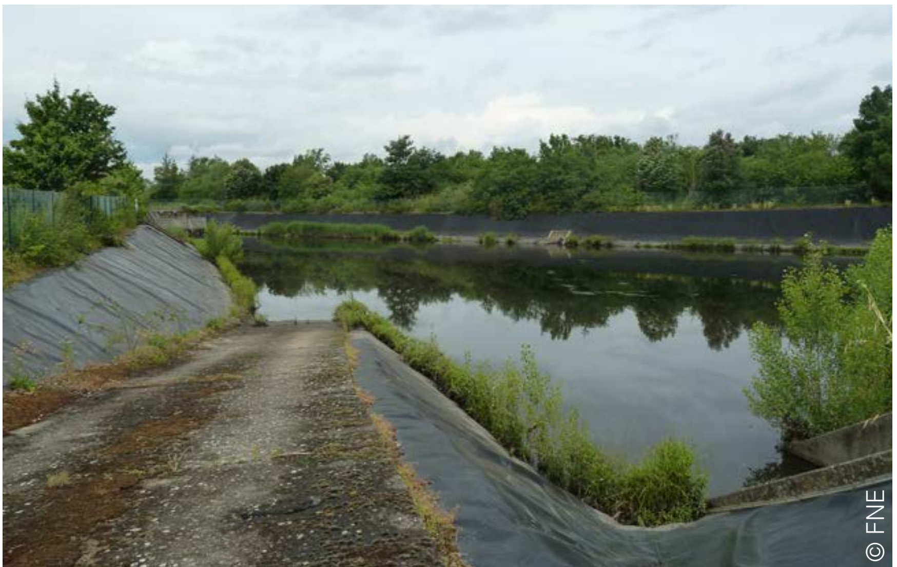
Bassin de rétention « un an »
