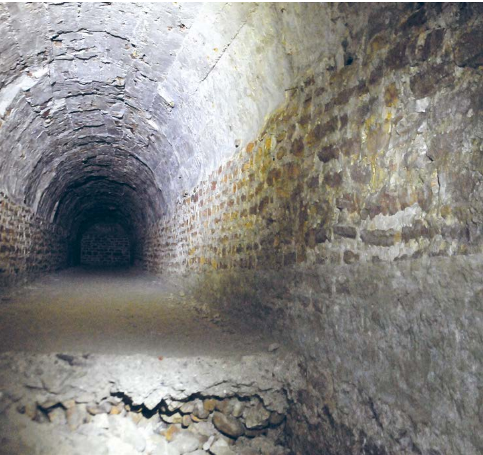
↑ Toutes les arêtes de poisson mesurent 30 mètres de long et plus de 2 mètres de hauteur.
